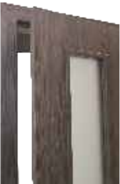
obložková zárubeň, falcové (polodrážkové) dveře
