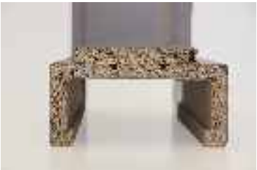
obložková zárubeň konstrukce SEPOS v řezu
