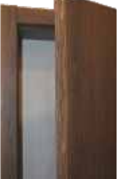
obložková bezfalcová zárubeň VERTIKAL, bezfalcové dveře
