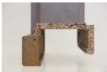
OKZ 60 mm konstrukce SEPOS v řezu
